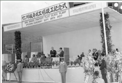
인천 판유리공장 준공식 (CET0030788)
